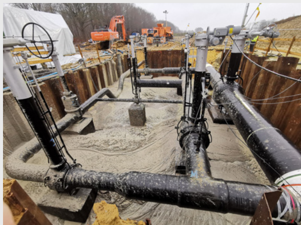
Bild 3: Station Marbeck bei vorangeschrittener Verfüllung
