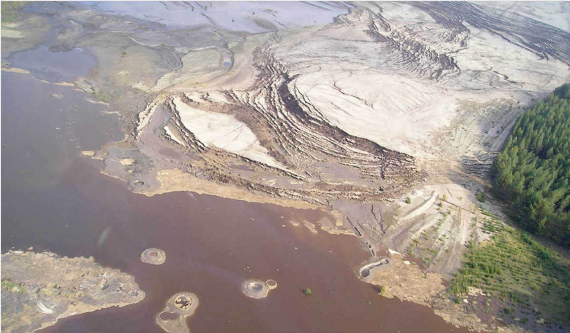
Bild 1: Setzungsfließbrutschung in einem ehemaligen Braunkohlentagebau
