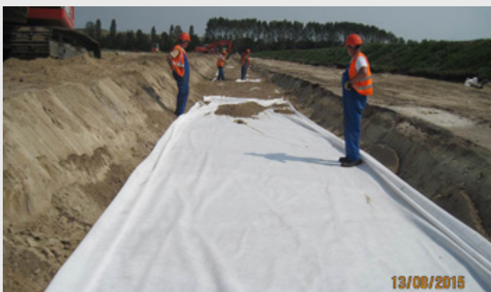
Bild 5: Eingebautes Geotextil auf der FGL 214 DN 800 DP 63
