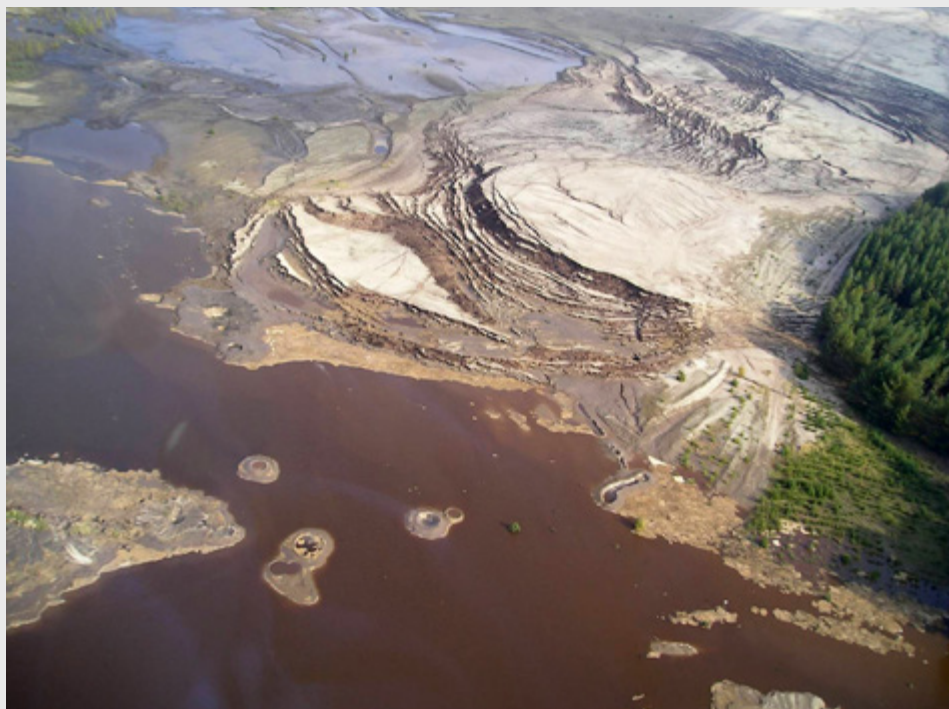
Bild 1: Großflächige Bodenbewegung durch Setzungsfließen in einem alten Tagebau (ONTRAS)
