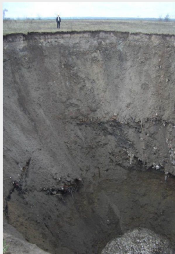
Bild 1: Tagbruch vom 30.3.2010 Grube Friedenshall
