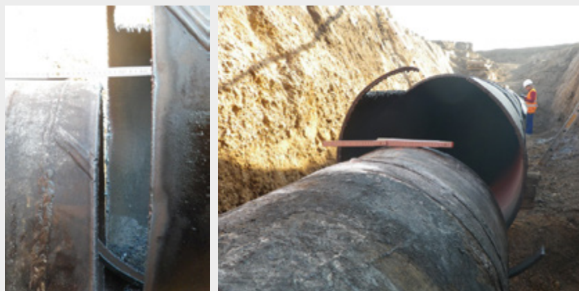
Bild 3: Leitung nach Trennschnitt
