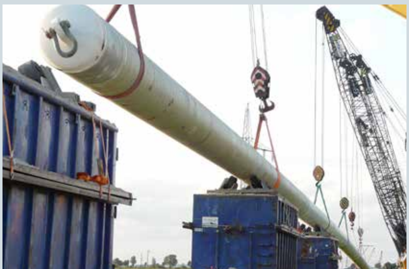
Bild 3: Auflegen eines Rohrstrangs in eine Oberbogenkonstruktion
