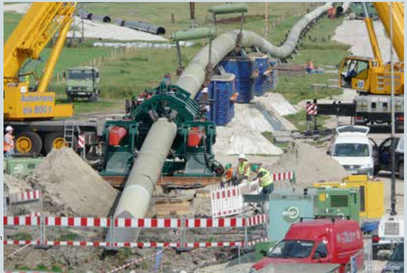
Bild 2: Oberbogen während des Einziehvorgang
