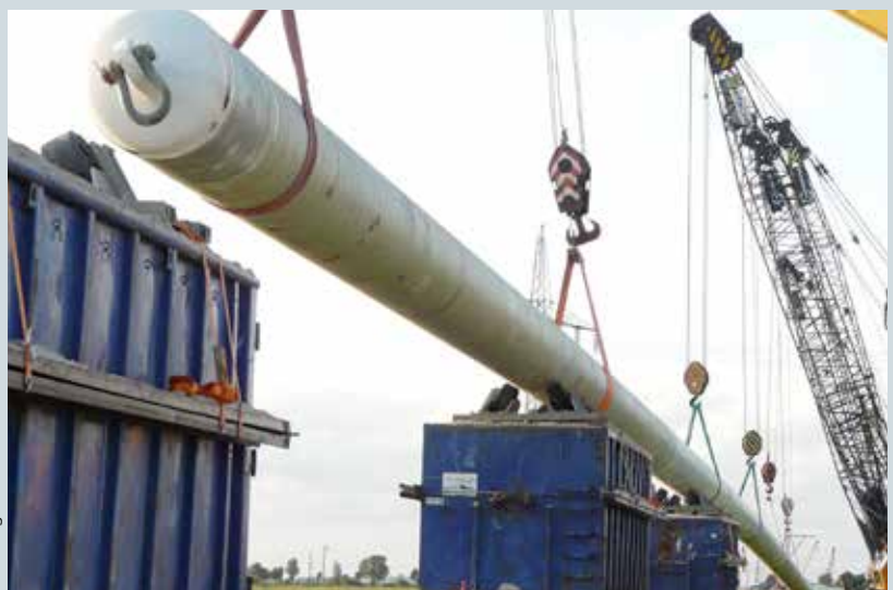
Bild 3: Auflegen eines Rohrstrangs in eine Oberbogenkonstruktion
