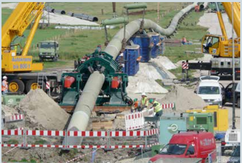
Bild 2: Oberbogen während des Einziehvorgang
