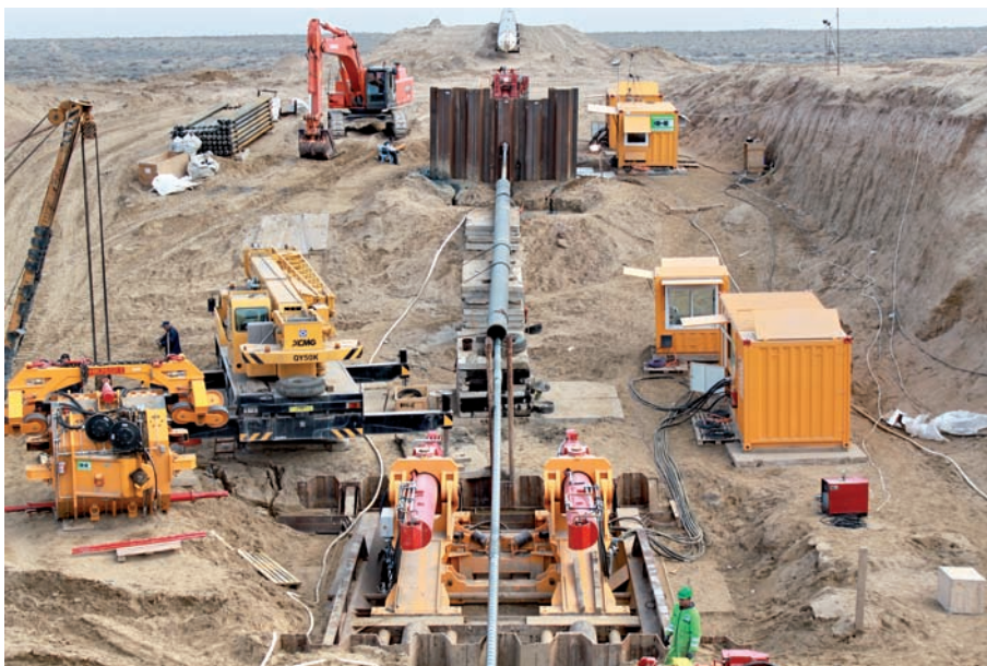
Bild 4: Aufweiten des 72“-Bohrkanals mit zwei Bohranlagen (Baugrube mit Pipe-Thruster im Vordergrund) Fig. 4: Widening of the 72“ drilled duct using two drilling rigs (working pit and pipe thruster in foreground)
