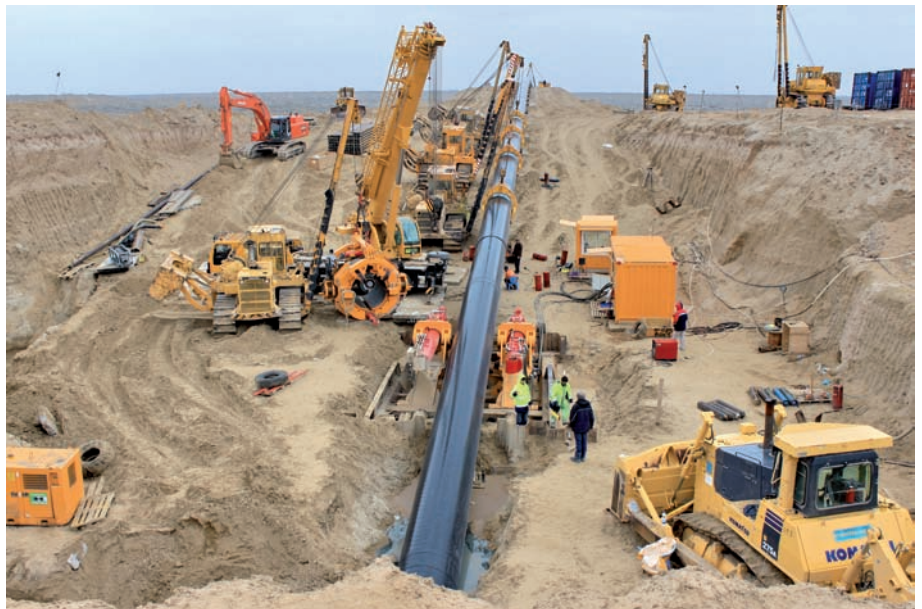
Bild 5: Einzug der 56"-Leitung
