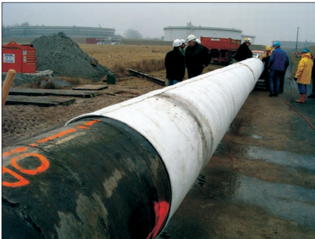
Bild 3: Probekörper mit Rohrschutzmatte
