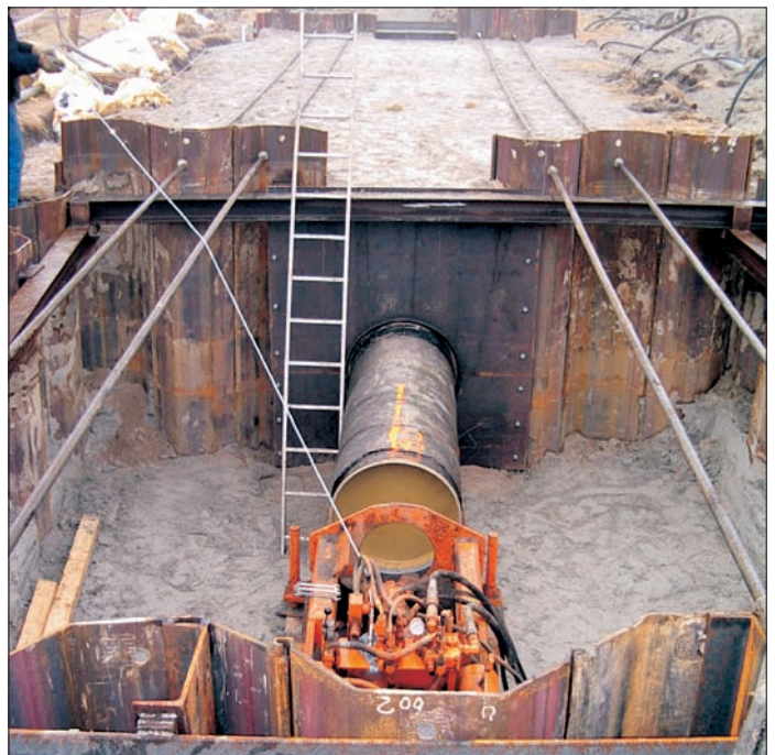
Bild 1: Versuchsstrecke - Pressgrube
