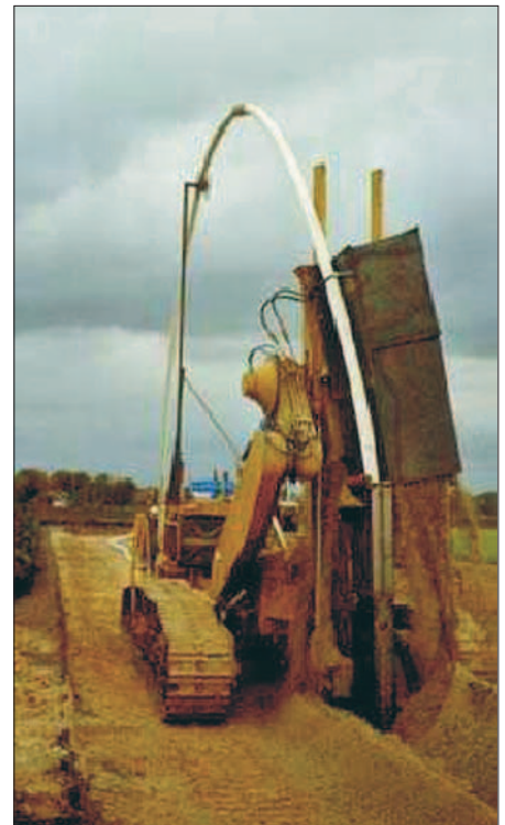
Bild 4: Verlegung eines aramidbewehrten Kunststoffrohrs Fig. 4: Installation of RTP pipe
