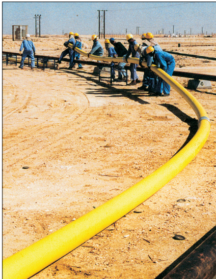
Bild 5: Verlegung eines aramidbewehrten Kunststoffrohres (Werksbild der Firma Tubes d'Aquitaine)
