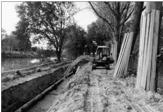
Bild 2: Blick auf den Rohrgraben und die Gashochdruckleitung
