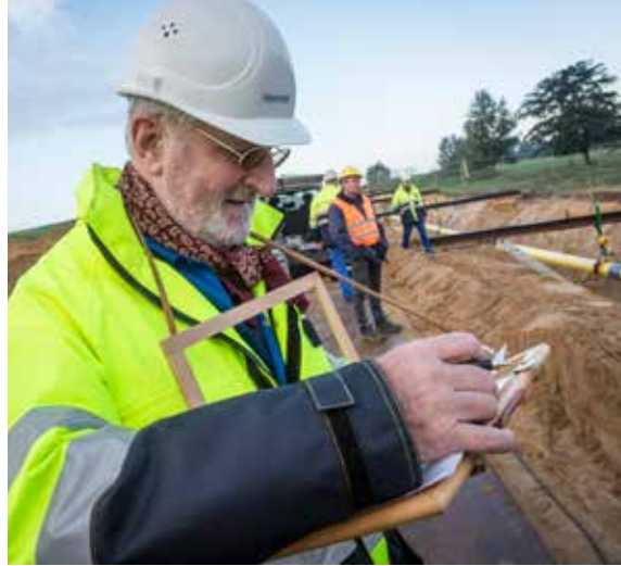
Bei ihm liefen die Fäden zusammen: Am Tag des Absenkens übernahm Dr. Manfred Veenker selbst das Kommando auf der Baustelle.
